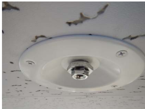
開放型ヘッドの取り付け完了
