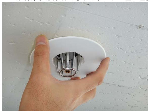
シーリングプレートの取り付け
