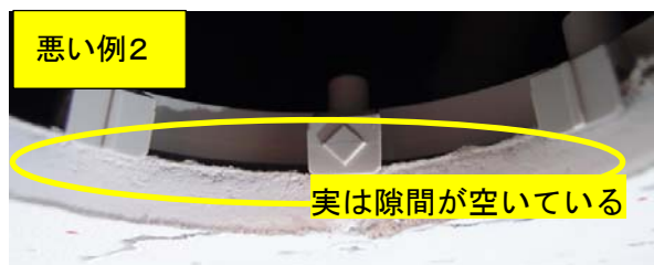
固定プレートの取り付け
