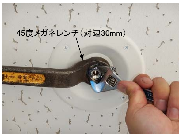
固定ナットの締め込み
