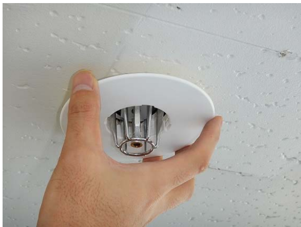
シーリングプレートの取り付け
