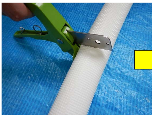
保温材の上から切断
