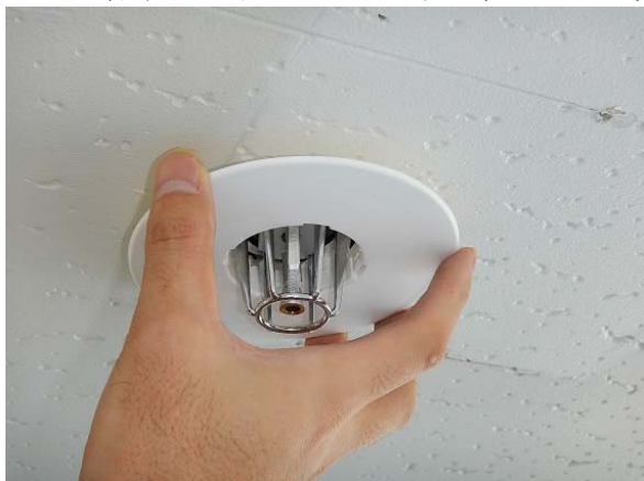
シーリングプレートの取り付け
