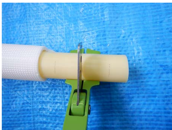
保温材を外した部分を再度切断する
