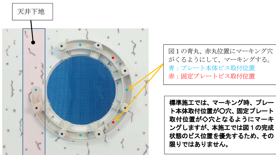
図2. マーキング（天井下から見た状態）
