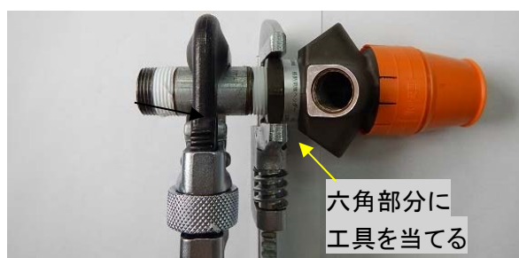
感熱開放ヘッダーと短管の接続
