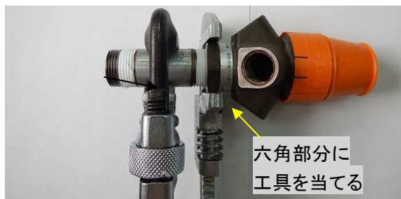
感熱開放ヘッダーと短管の接続
