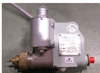
起動弁開放装置の作動状態
