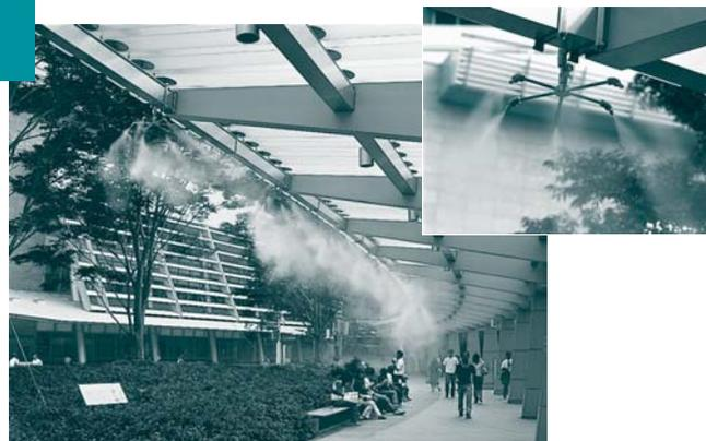
ドライミストは、微細な水の粒で人工的な霧を発生させて、水が液体から気体に変わる際に周囲から熱を奪う気化熱を利用して周辺の気温を下げるシステムで、当社を含むコンソーシアムで共同開発いたしました。
