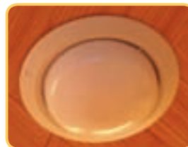
◀スプリンクラー (コンシールドヘッド)
