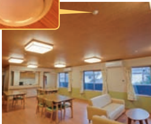
◀スプリンクラー (コンシールドヘッド)
